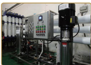
めっき排水再利用装置
