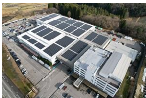
太阳能发电设备（屋顶部分） 富山事业所
