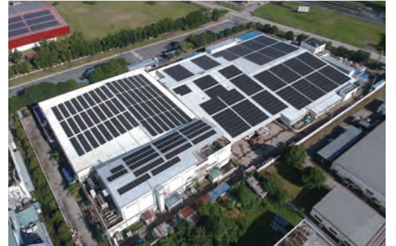
SMK-PHの太陽光発電設備
