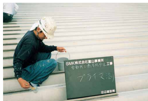
塗装工事の様子
