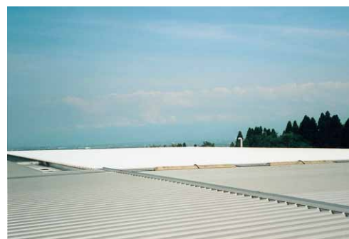
太陽熱遮断塗料塗装後の屋根
